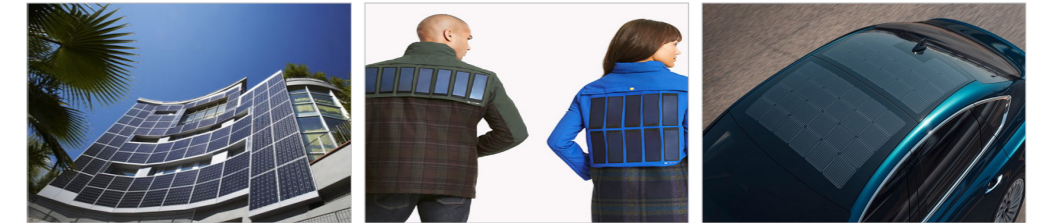
[건축물 일체형 태양광]
